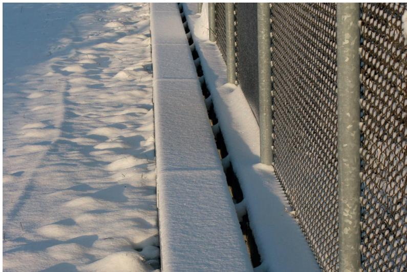
El sistema de bandejas industriales aislantes Unex se diseña teniendo en cuenta la absorción de dilataciones. La distancia “**d**” entre dos tramos de bandeja industrial o tapas varía en función de la diferencia entre la temperatura máxima y la temperatura de instalación.
