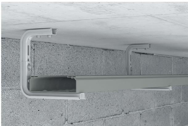
**Dos soportes L** en acero galvanizado con pintura epoxy gris.
