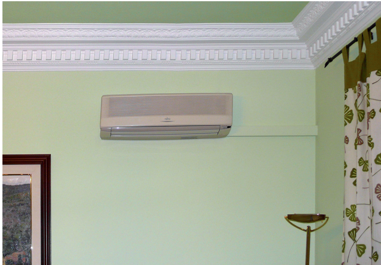
Rehabilitación de viviendas
