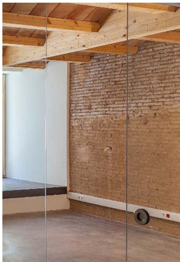
Espacios de trabajo: rehabilitación de oficina
