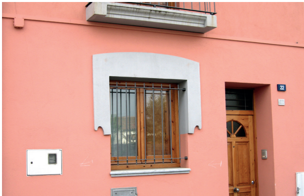
Distribución de líneas repartidoras en vivienda mediante moldura.
