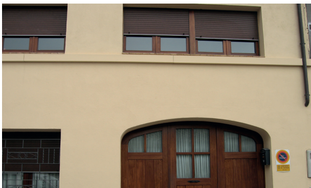
Distribución de líneas repartidoras en vivienda. El pintado permite integrar estéticamente la canal en el edificio.
