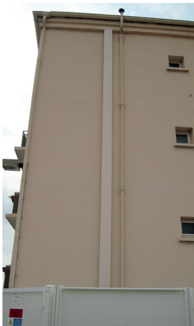
Alimentación de antenas de telefonía móvil. Ofrece protección a los cables coaxiales.
