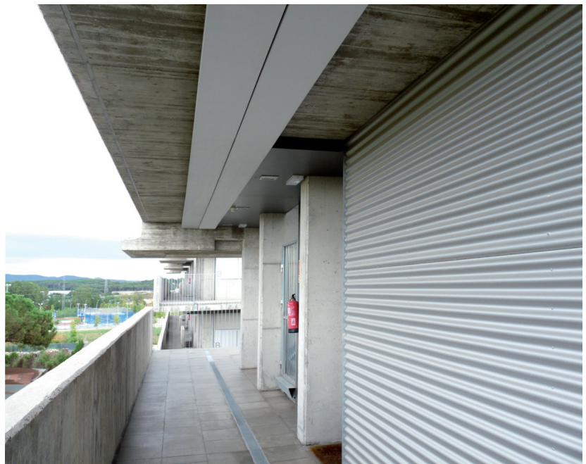
Canalización de instalaciones de servicios comunes, instalaciones de enlace e ICT. El gran ajuste de la tapa y el puente retenedor permiten montar la canal boca abajo.
