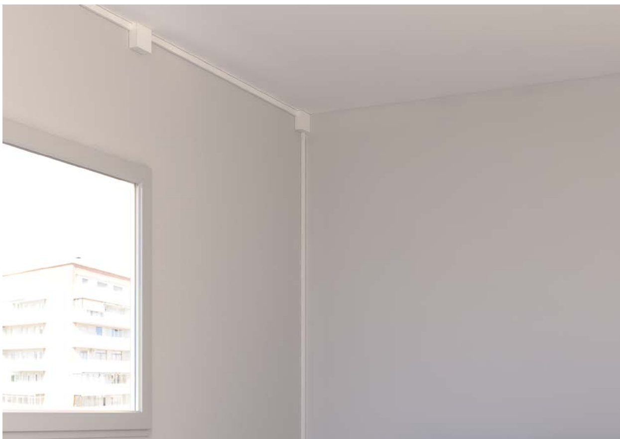
Réhabilitation de logement
