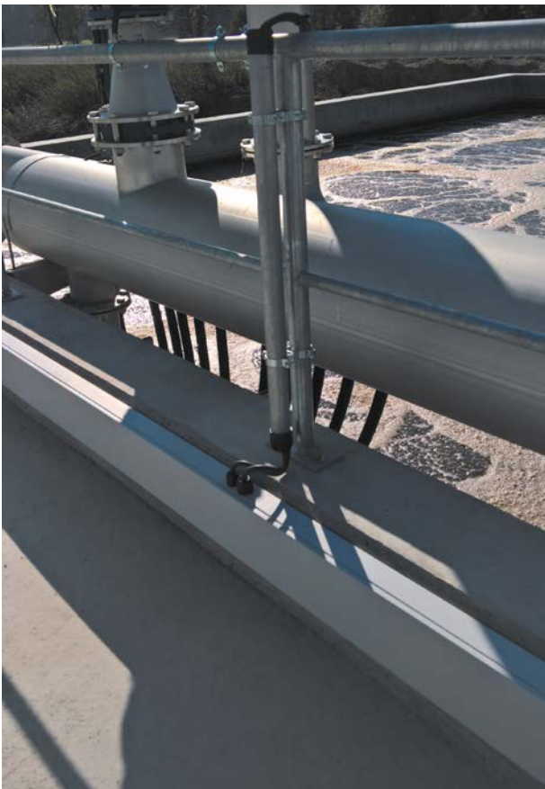
Traitement des eaux : Station d'épuration
