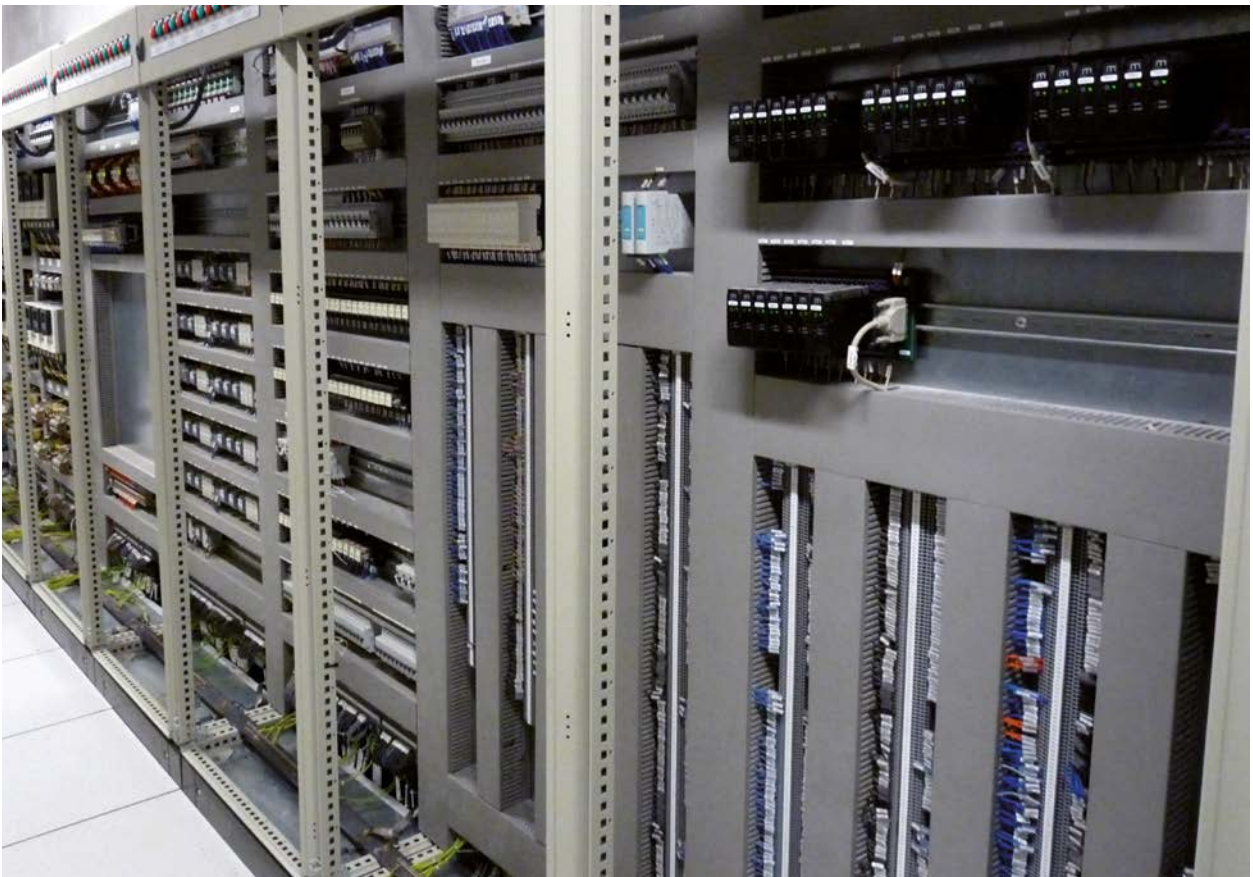
Traitement de l'eau
