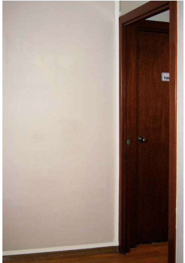
Ristrutturazione di residenze civili
