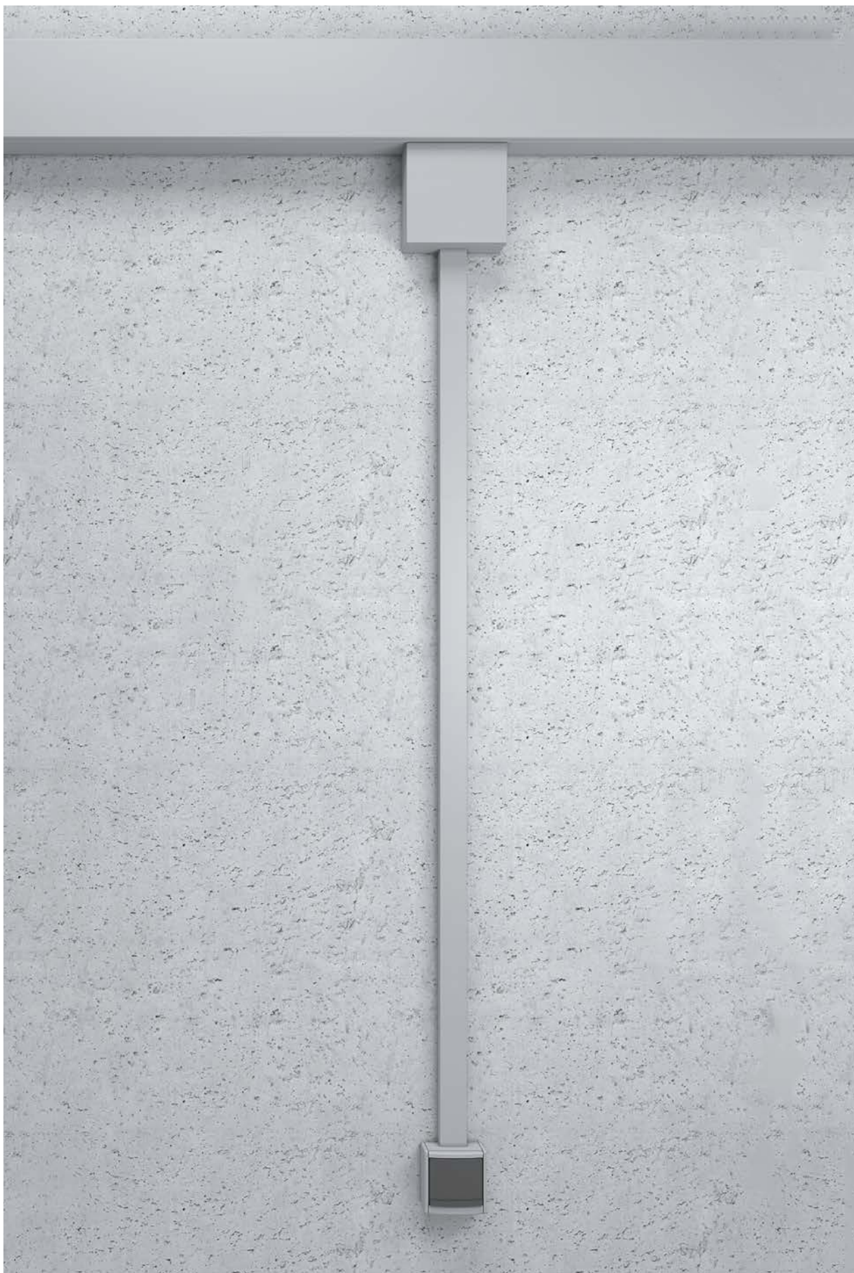
Nave industrial: adaptação de mecanismos
