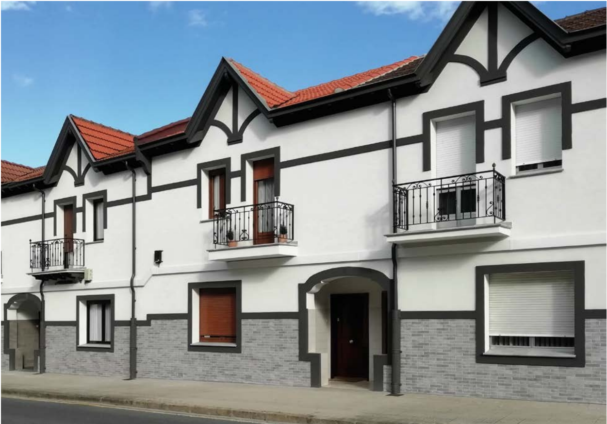
Habitação: distribuição pela fachada
