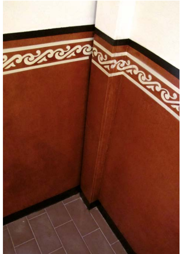
Reabilitação de um edifício de habitação
