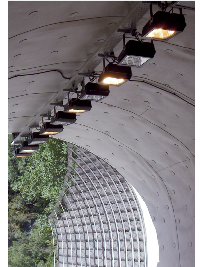
Infraestrutura rodoviária: túnel
