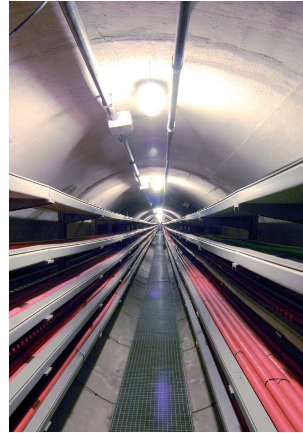
Aeroporto: galeria técnica
