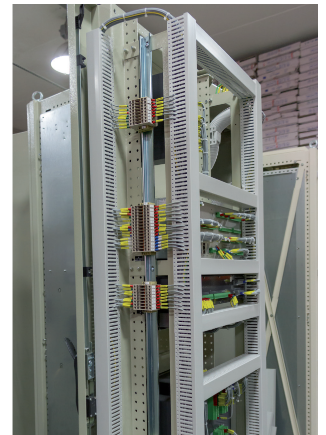
Produção e distribuição energia elétrica
