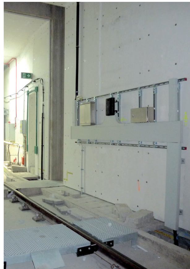
Infraestrutura ferroviária: túnel
