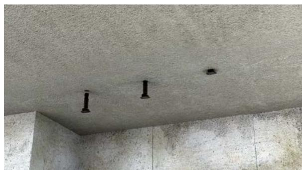
O taco de pressão Unex instala-se facilmente na parede graças ao desenho das suas hélices, que por sua vez asseguram o encaixe do taco na parede e oferecem resistência à sua extração, inclusive a baixas temperaturas.
