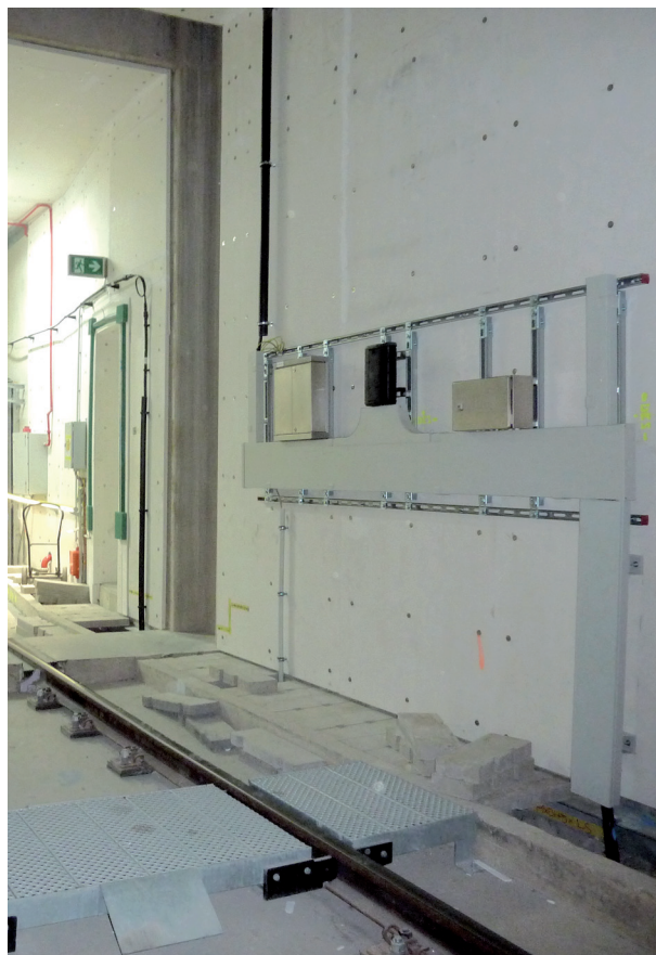
Infraestructura ferroviaria: túnel
