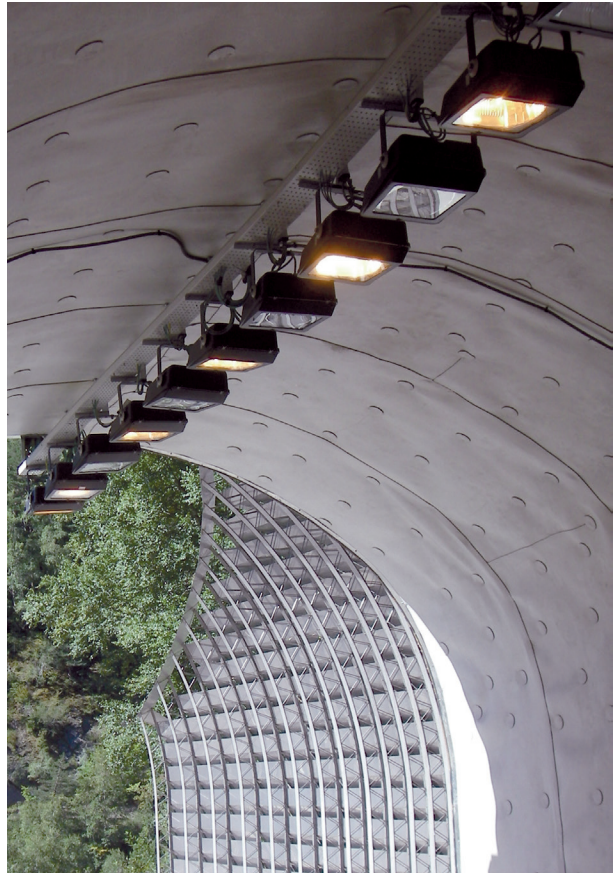
Infraestructura viaria: túnel
