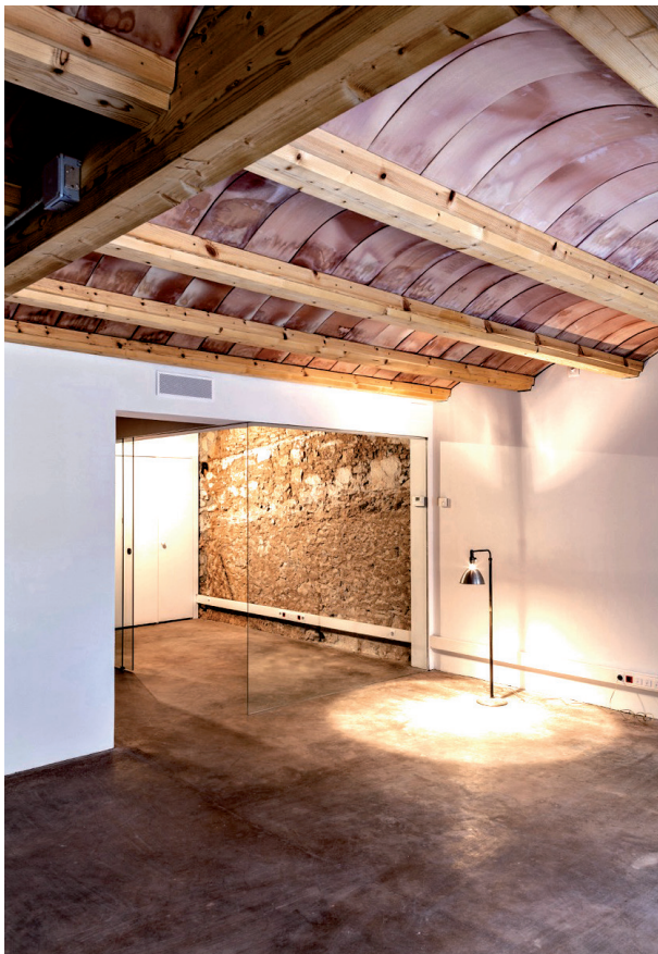
Espacios de trabajo: rehabilitación de oficina
