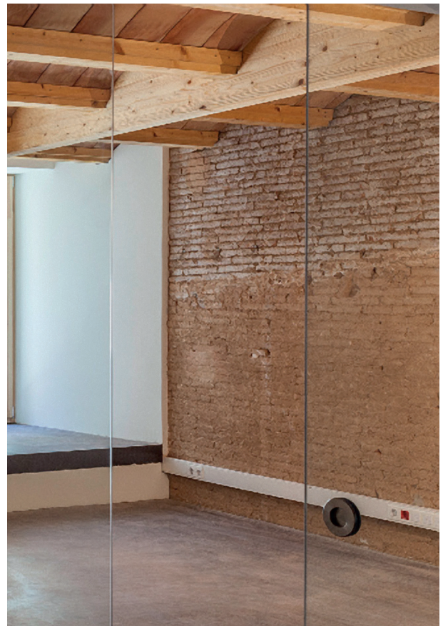
Espacios de trabajo: rehabilitación de oficina
