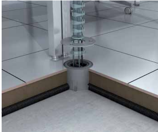
Obra nueva a través de la capa de nivelación.
