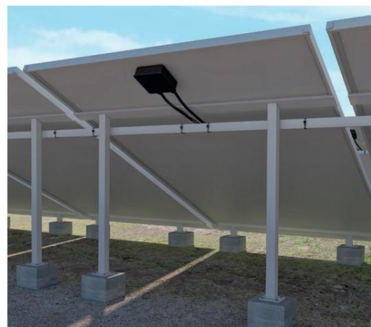
Je nach Beschaffenheit des Geländes kann die Verkabelung der Stränge oberirdisch in Kabelkanälen oder unterirdisch verlegt werden. Die Verwendung der isolierenden Unex-Kabeltragsysteme wird dringend empfohlen, da sie das Risiko von indirekten Kontakten, Leckströmen und Lichtbögen verringern, die Verkabelung schützen und die Leistung der Anlage verbessern.
