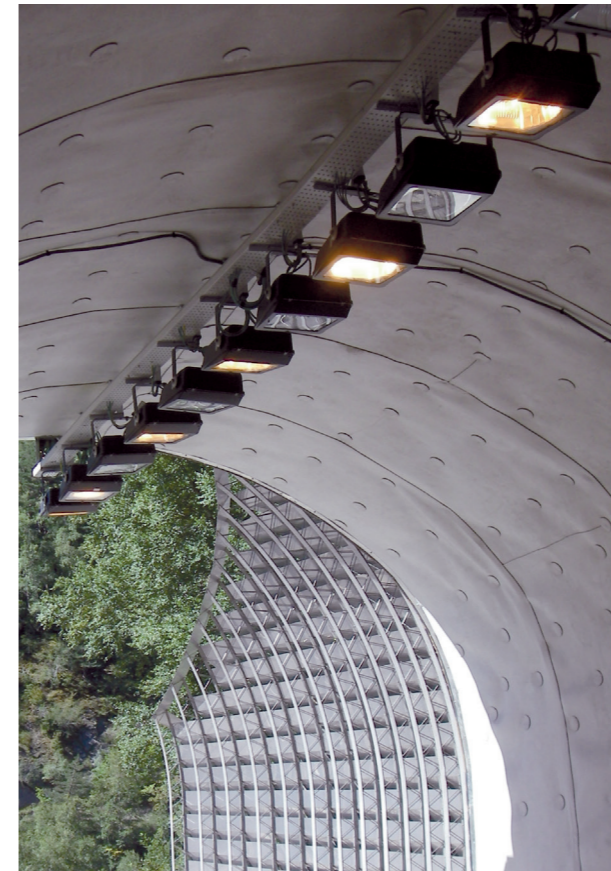
Infraestructura viaria: túnel
