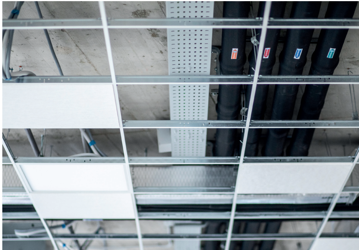
Espacio de trabajo: oficina
