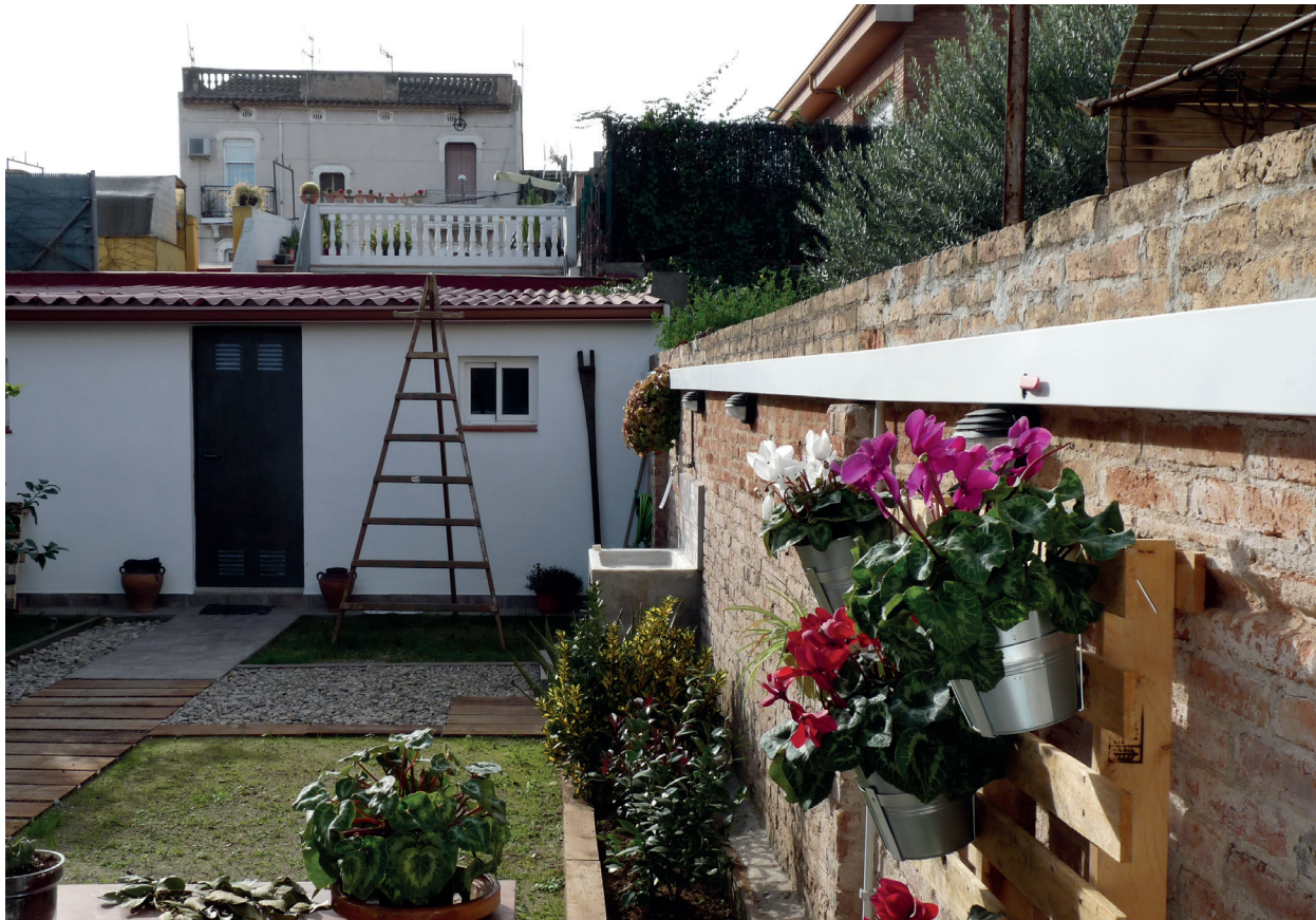
Rehabilitación de viviendas
