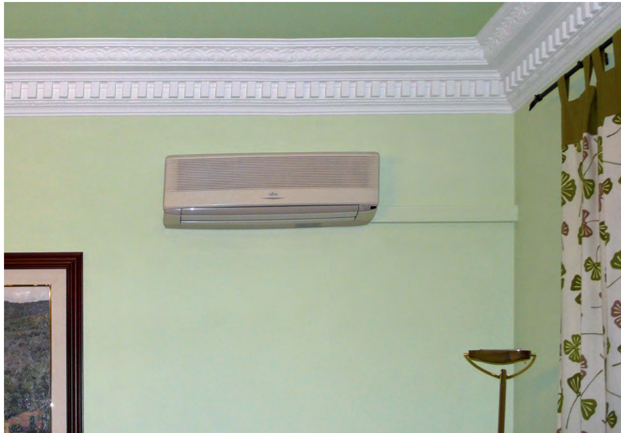
Rehabilitación de viviendas
