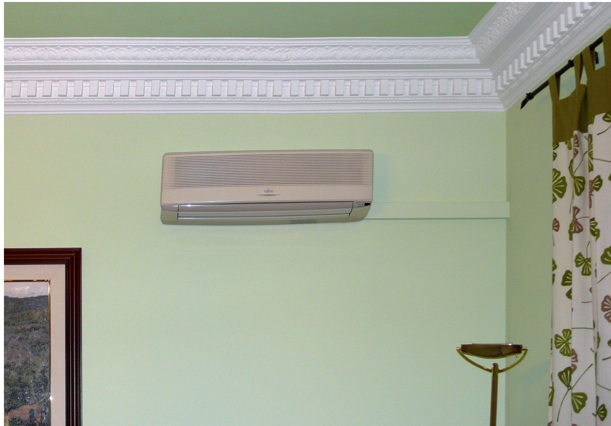
Rehabilitación de viviendas
