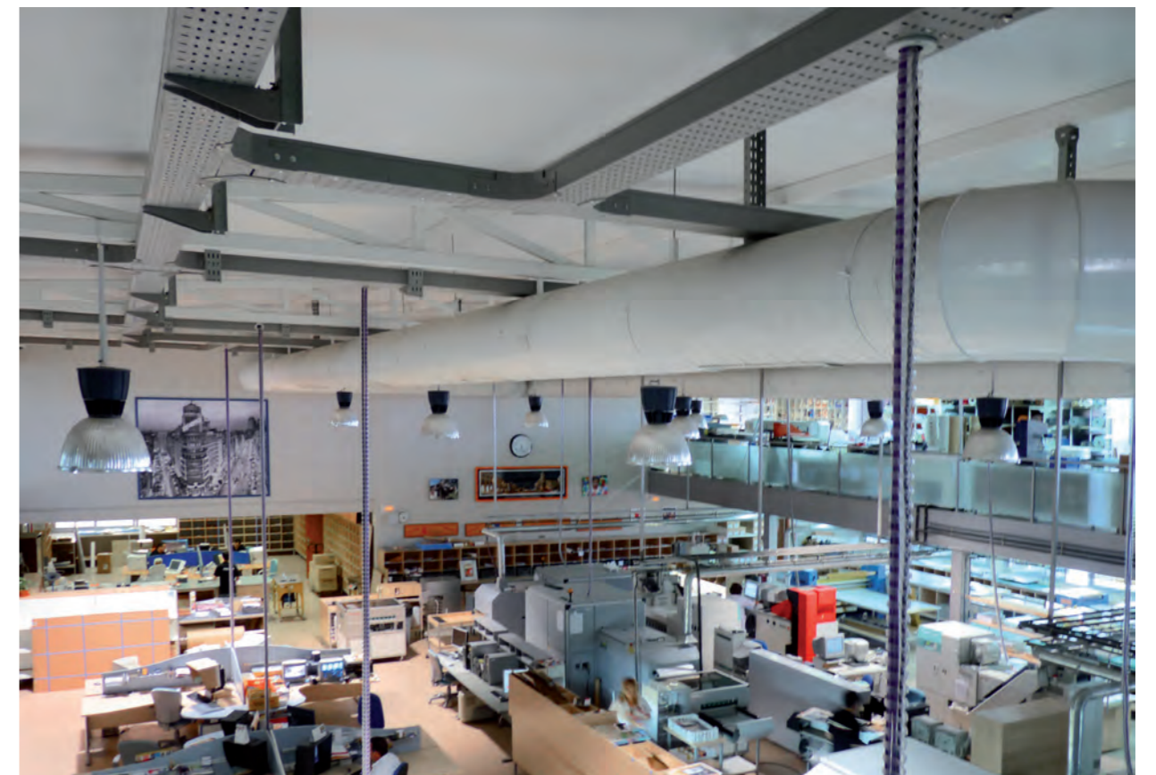
Nave industrial: oficina
