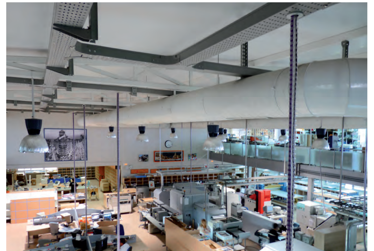
Nave industrial: oficina
