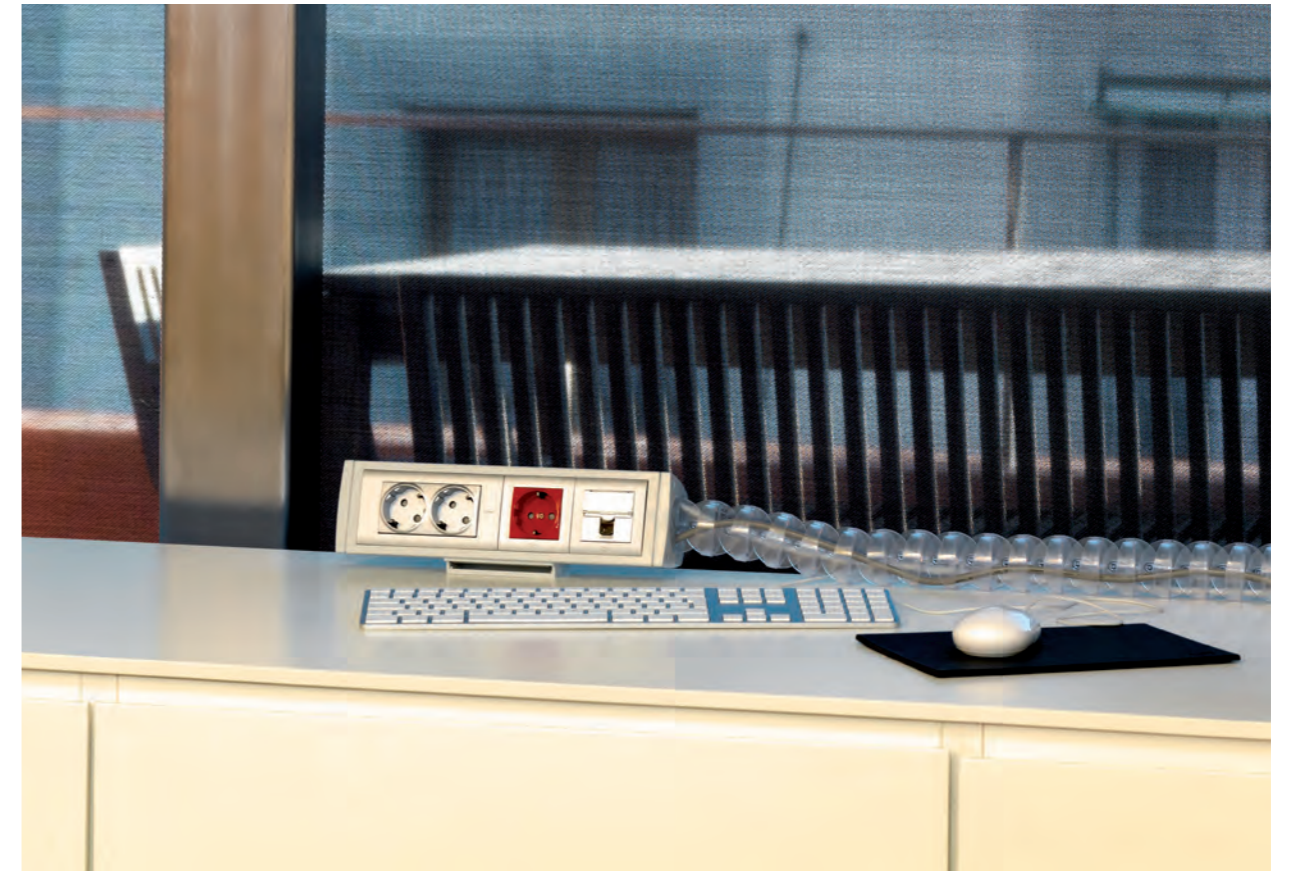
Puesto de trabajo: oficina
