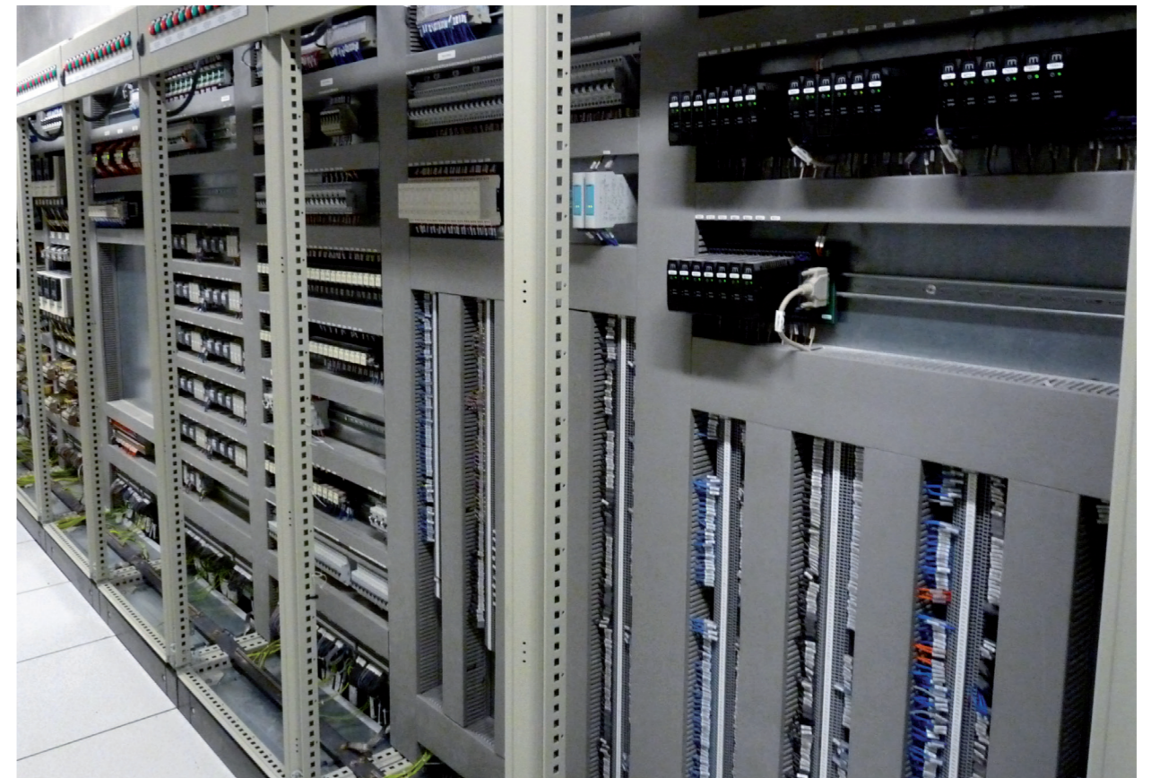
Traitement de l'eau
