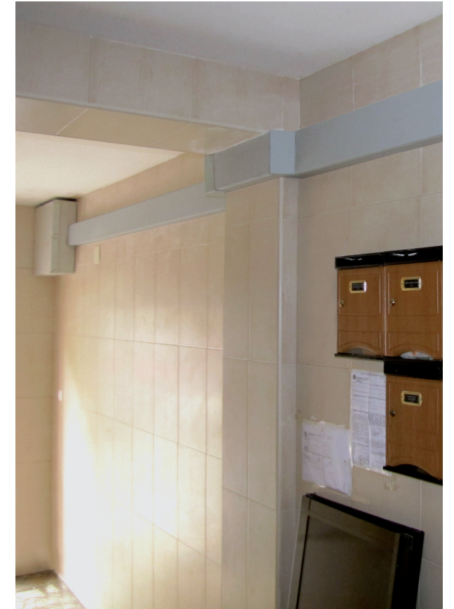
Réhabilitation de logement
