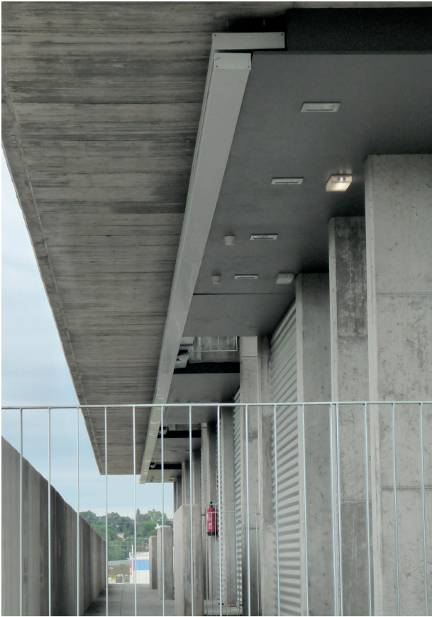
Abitazioni: impianti TLC e IT
