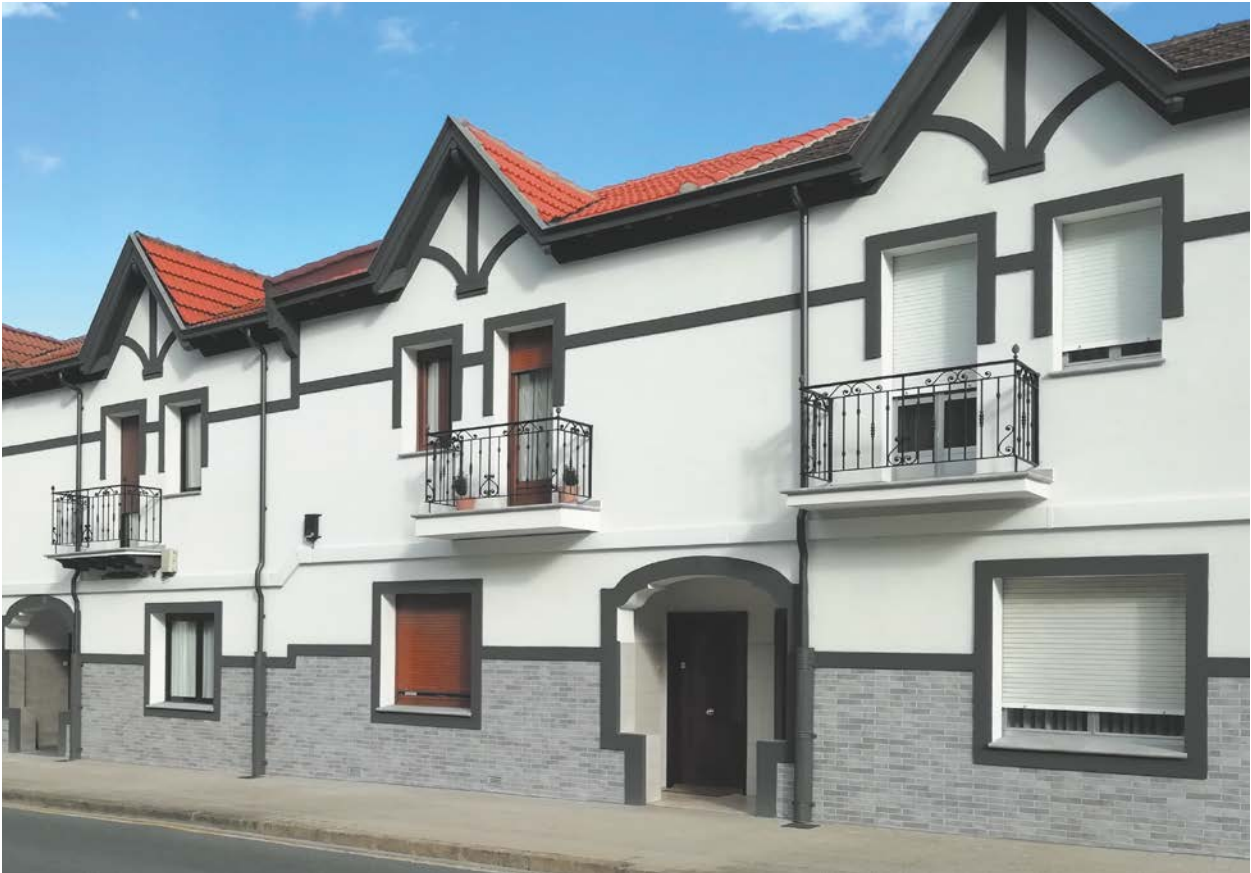
Budownictwo: rozprawienie na elewacji
