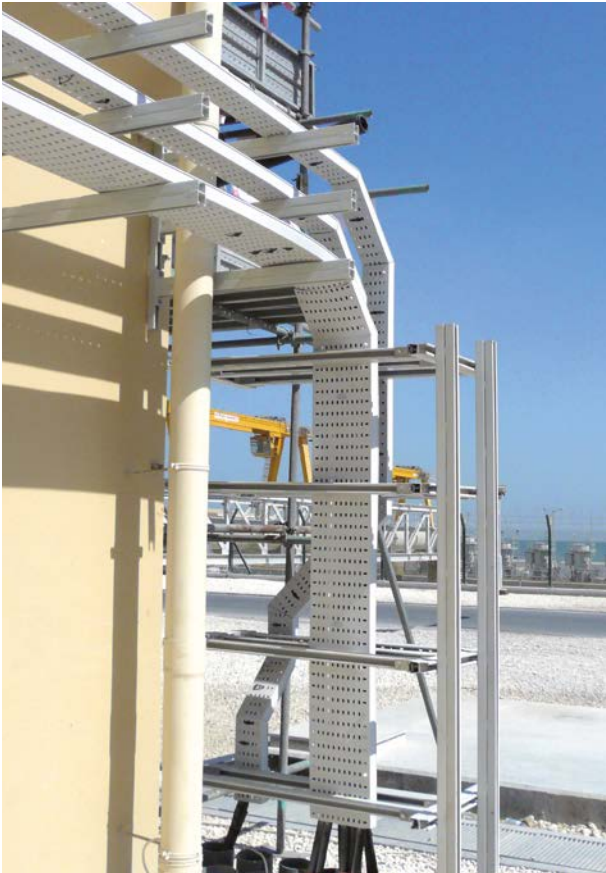
Oczyszczalnię ścieków: stacja odsalania wody
