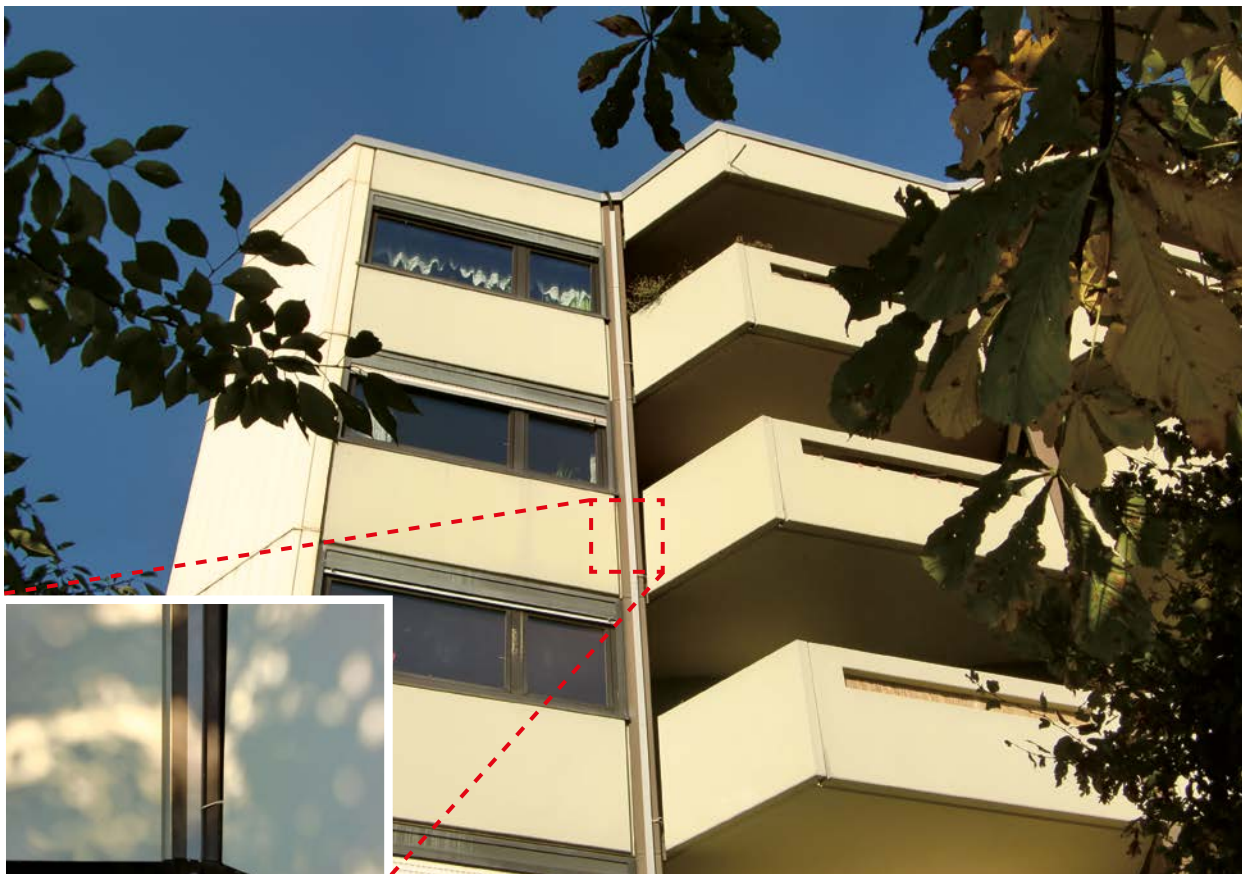
Budownictwo: rozprawadzenie na elewacji
