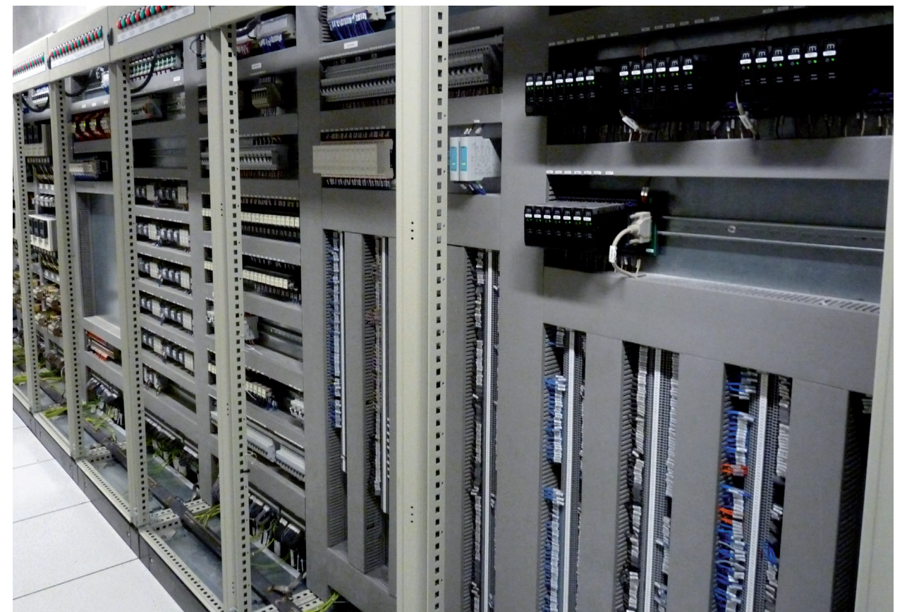
Tratamento de águas
