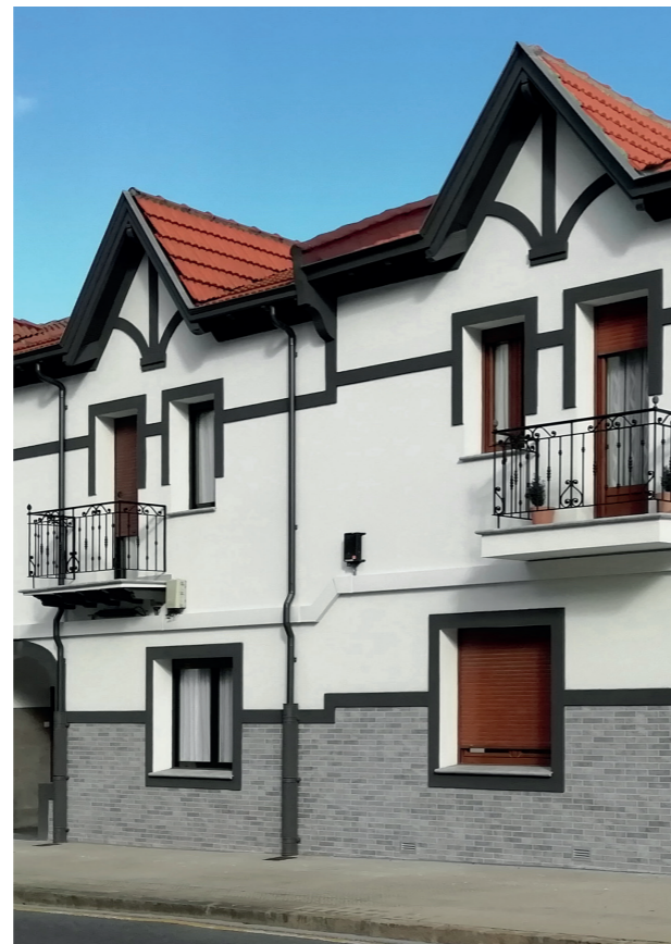
Habitação: distribuição pela fachada
