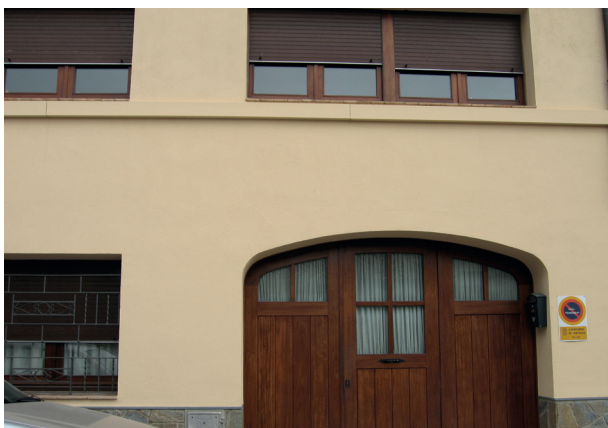
Distribuição de energia em edifícios de habitação. A pintura permite integrar esteticamente a calha no edifício.
