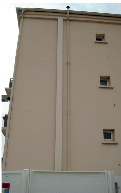
Alimentação de antenas de rede de comunicações móveis. Oferece proteção aos cabos coaxiais e de fibra ótica.
